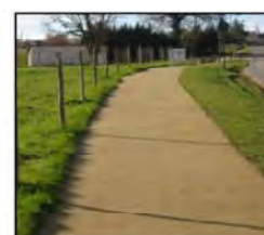
Sablé stabilisé renforcé
