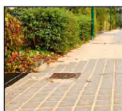
Pavé bétons avec joints sablés
