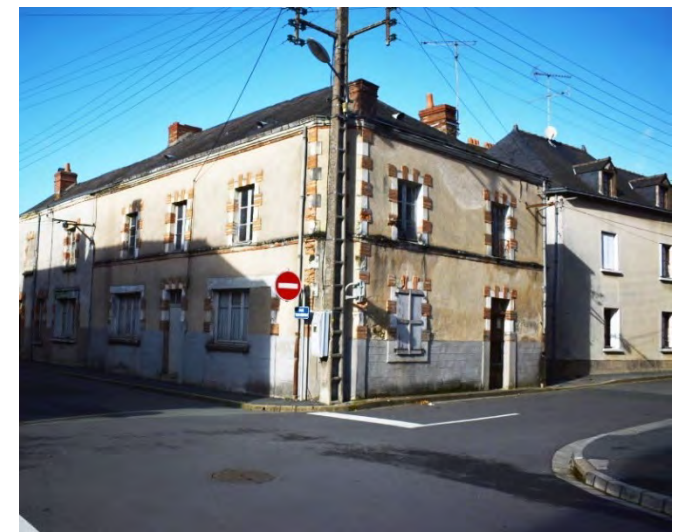
Angle rue Tournebride et rue du Pavé
