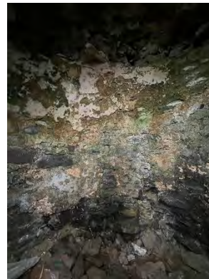
4- intérieur de la tour (au 5 rue de l'ancien collège) © BE-AUA
