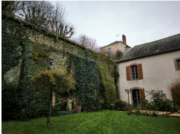
2- Soutènement de la place de l'église Saint-Nicolas © BE-AUA
