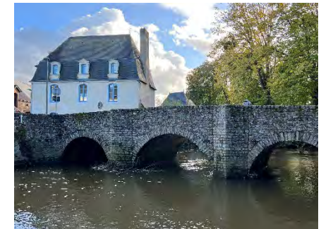
Rue du Vieux Pont © BE-AUA
