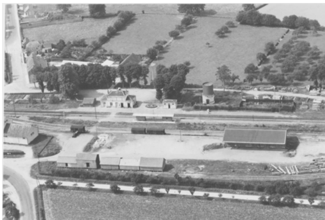
Cote AP53HN0027 - vue aérienne de la gare de Craon – fonds Roger Herrnard, 1945-1975 - Médiathèque du patrimoine et de la photographie – ministère de la culture
