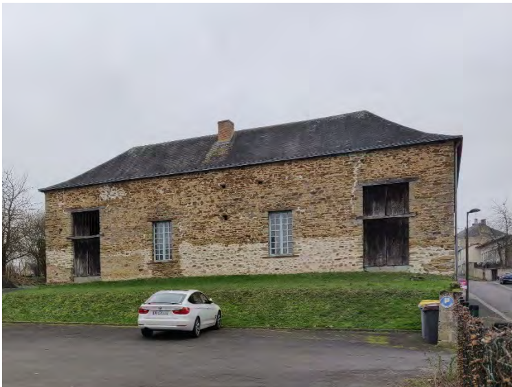
Le grenier à sel, rue du pavé © BE-AUA
