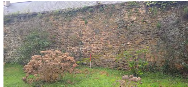
8 – rempart potager du château
