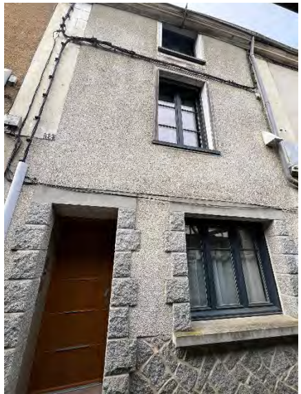
Place des Halles – ban de bois recouvert
