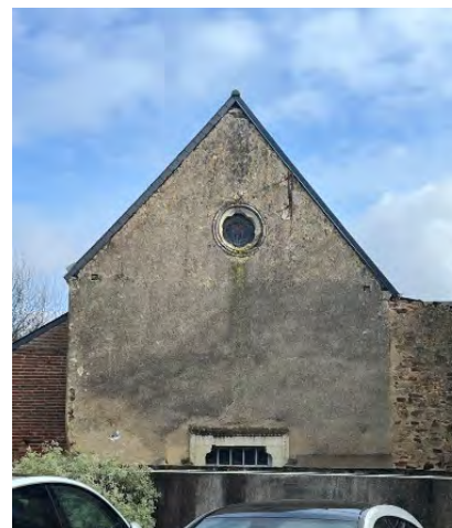
Chapelle derrière la rue de la Libération
