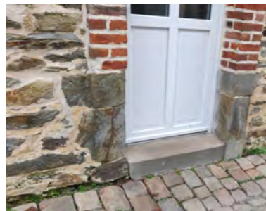
Photographies des roches et matériaux présents dans les constructions de Craon : granite, grès, schiste, siltite, calcaire, brique, © MM 2024
