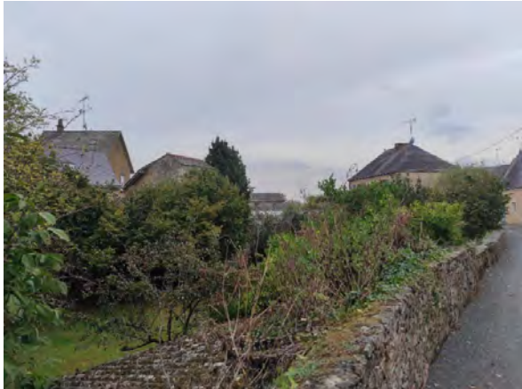
Rue des douves - mur de soutènement/mur de clôture bas © BE-AUA
