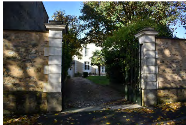
Promenade Charles de Gaulle - mur de clôture haut (destiné à être enduit) et piliers en pierre de taille © BE-AUA
