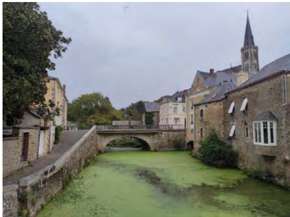
Entre le Vieux pont et le rue de la Libération - mur de soutènement © BE-AUA
