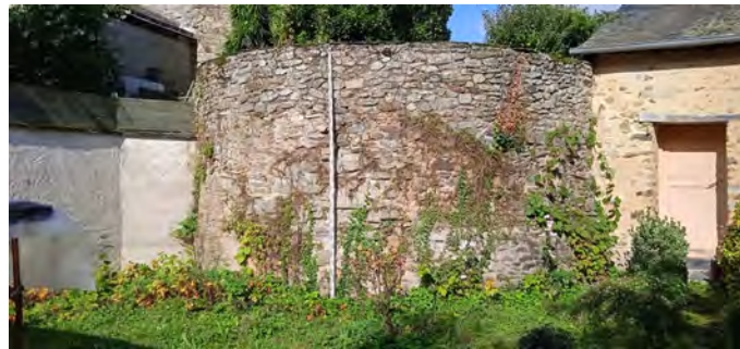
12 – tour dans une propriété rue des Halles
